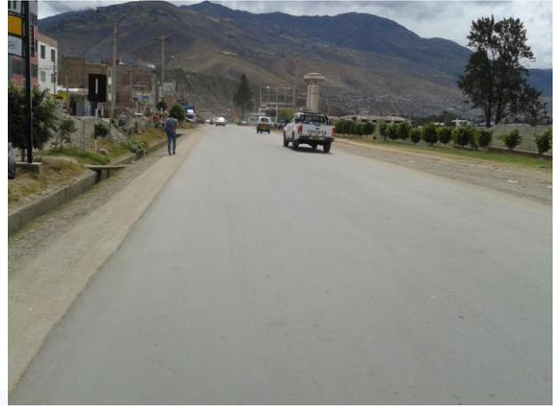
**Estabilización de Pavimento** - Se estabilizo la base a 15cm y se selló con 2" de Asfalto. Se logró una buena estructura con una mayor resistencia y flexibilidad que no mostrara ahuellamientos ni baches por años por venir - Huánuco Perú.
