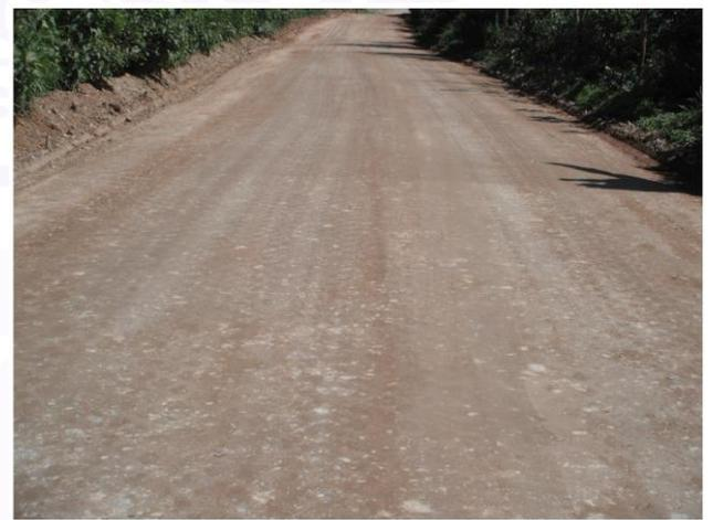
**Tratamiento a nivel Afirmado** – Suelo arcilloso de baja resistencia con lugares arenosos y gravosos, se logró garantizar una mejor calidad y mayor duración de la superficie, con menos daños de tráfico – Cajamarca Peru
